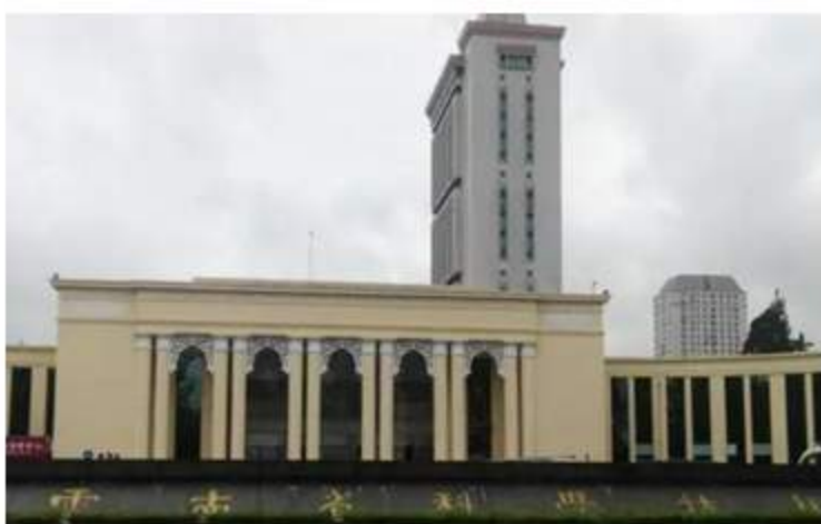
云南省科技馆 昆明航天分馆
